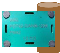
Une étiquette verte indique la présence de câble fibre optique
